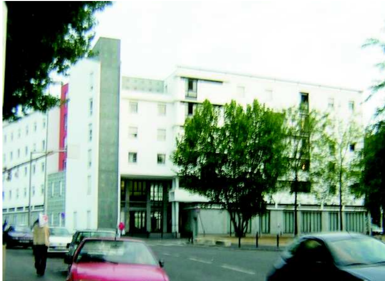
FIG. 11 – Vue de la résidence sociale Bachir Souni
