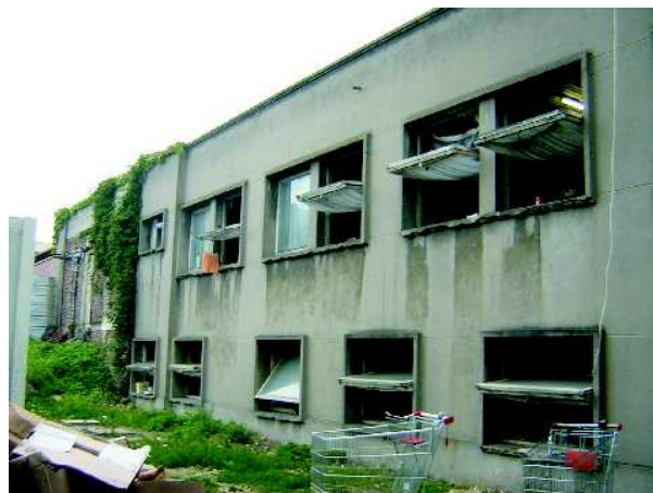
FIG. 7 – Vue de l'extérieur du bâtiment principal
